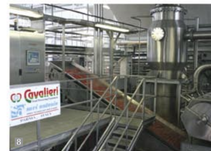
fig.8 Quadro elettrico con PLC e sistema di gestione con PC industriale
